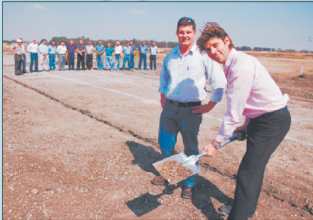
Die eerste soel is gespit en bouwerk het by die Riverspray Lifestyle Estate aan die Vaalrivier langs die Vaaldrivhoekekampus van die Noordwes-Universiteit begin. Inwoners sal na verwagting reeds binne die volgende jaar kan begin intrek. Die ontwikkelaars van die projek, mnr. Wynand Haywood en Willem Broeks (op die voorgrond), het die plaaslike boukontraakteurs, Solid Build (die groep in die agtergrond) as projekteur aangestel. Foto: Sarie van den Berg.
